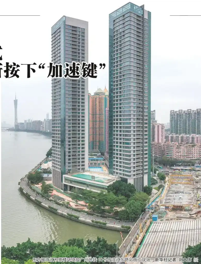
图为被环境和高楼环绕的广州地标，10号线地铁新站施工现场。新华社记者 刘大伟 摄
