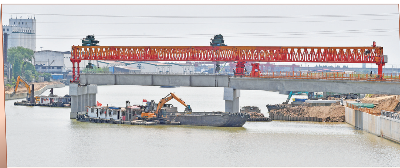
记者5月22日获悉，我市水利工程史上最大单跨径预制箱梁桥——东风桥开始箱梁架设。这座位于新孟河延伸拓浚工程范围内的桥梁，上部结构为单跨45米的预制箱梁，共分4跨，目前已完成第一跨箱梁架设，预计7月底完成整桥箱梁架设，下半年建成通车。该桥梁也是新孟河延伸拓浚工程常州段主线最后一座通车的桥梁。
